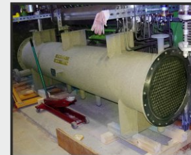
Abgaswärmetauscher Rohrleitungen, Bypass
