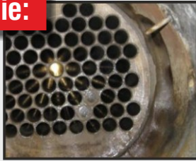
Abgaswärmetauscher, abgas- und wasserseitig
